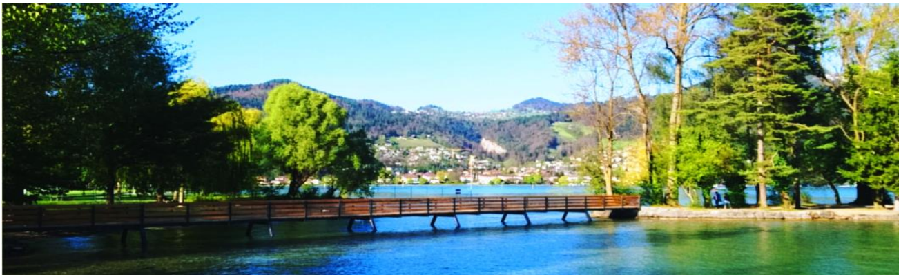
Neu renovierter Steg beim „Gründer-Inseli“
